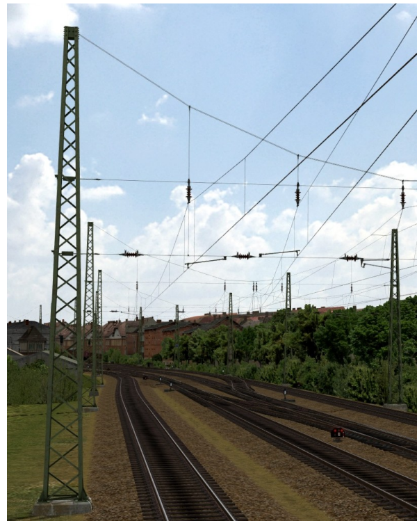
Fahrleitung zu Spannwerk zwischen Richtseilen
